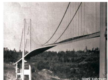
Bild 1 Die schwingende Tacoma-Brücke
